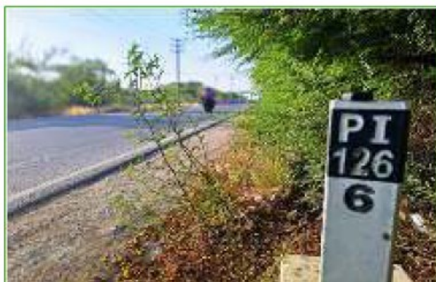
VISTA DE CARRETERA DE ACCESO
