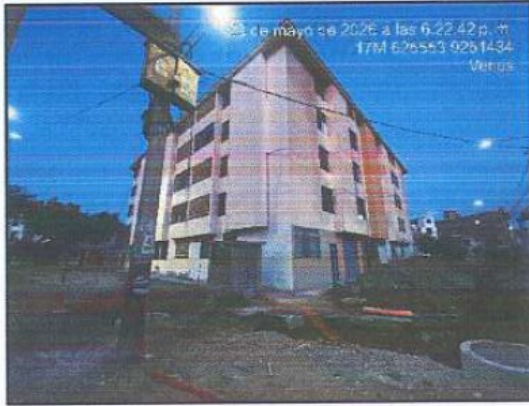
Fotografía 01: Fachada general de Inmueble
