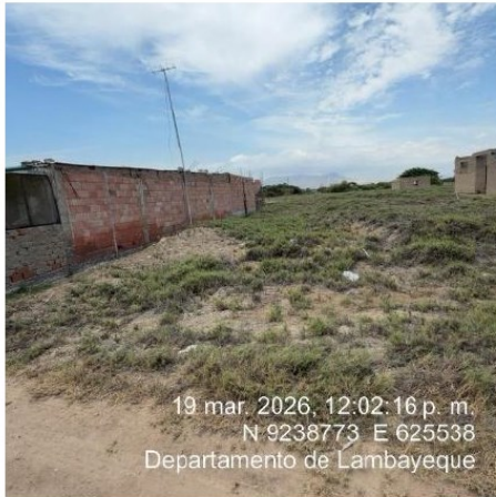
Fotografía 01: Fachada de Inmueble
