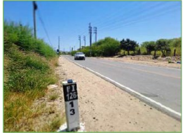
Vista de Carretera de Acceso
