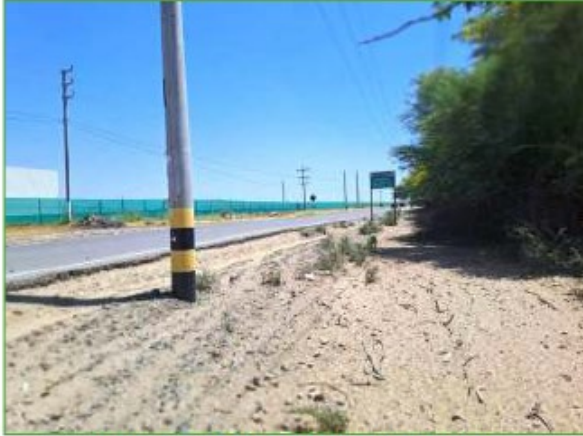
Vista de Carretera de Acceso
