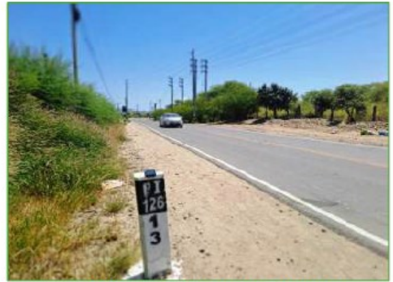
Vista de Carretera de Acceso
