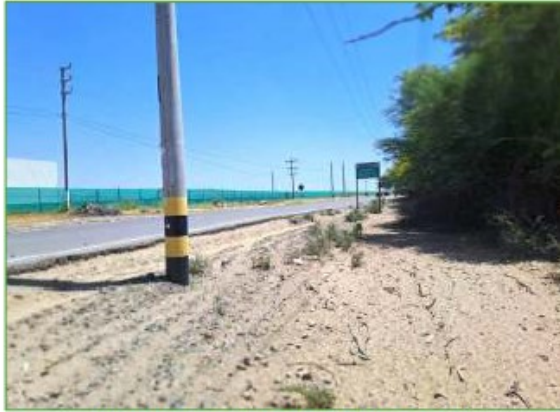
Vista de Carretera de Acceso
