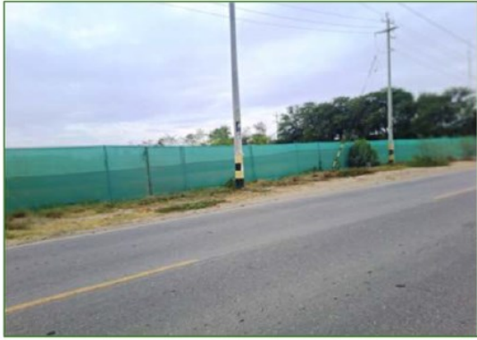
Otra vista externa del Predio
