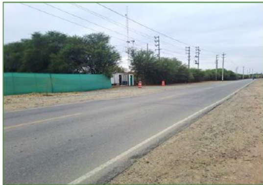
Vista de Carretera de Acceso
