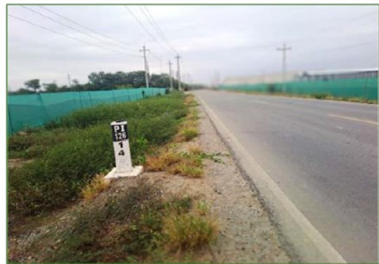
Vista de Carretera de Acceso
