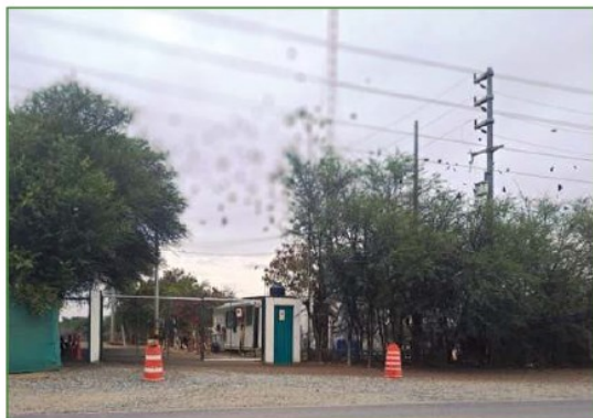
Vista Externa del Predio
