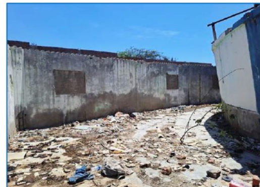
VISTA INTERIOR DEL PREDIO
