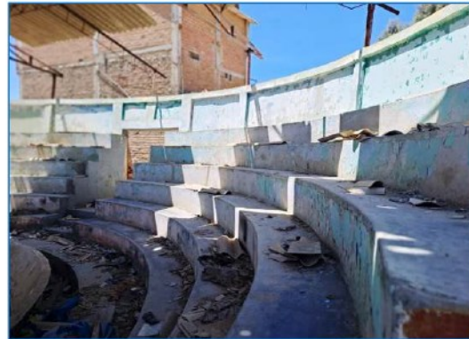
VISTA INTERIOR DEL PREDIO
