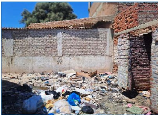
VISTA INTERIOR DEL PREDIO
