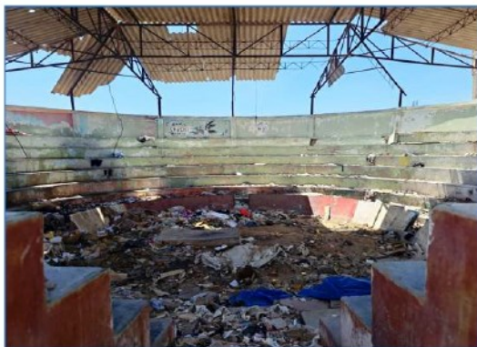
VISTA INTERIOR DEL PREDIO
