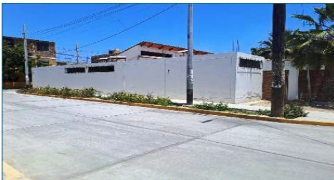
Vista Lateral del Bien Inmueble
