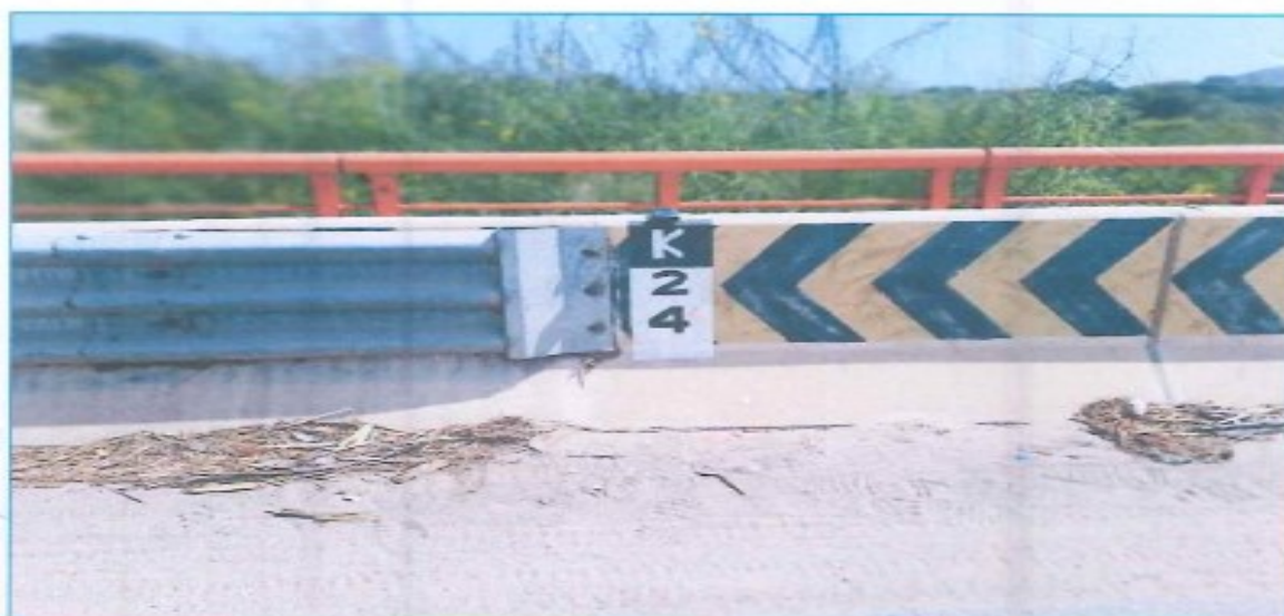
Vista Km 24 Puente Ignacio Escudero
