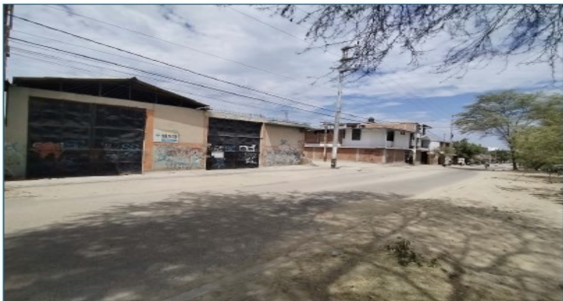
Vista de Acceso Principal y Frente del Bien Inmueble
