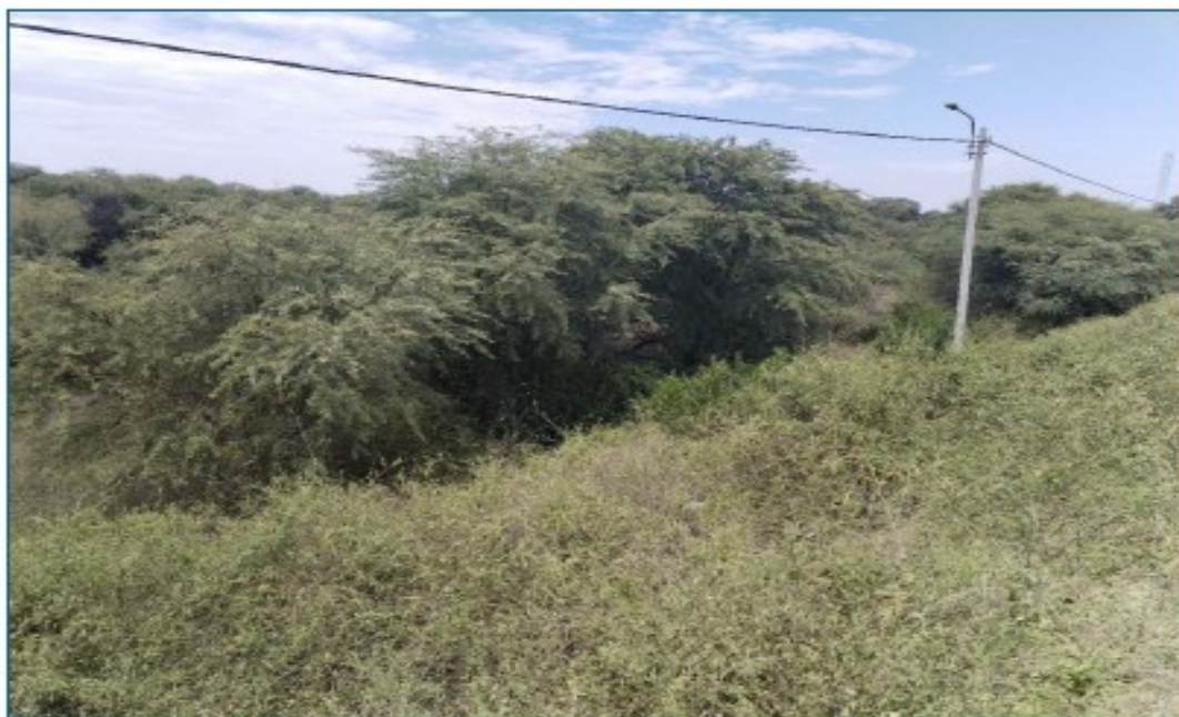
Vista de Infraestructura Urbana (Alumbrado Público)
