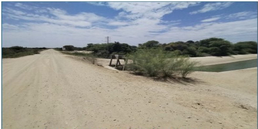
Vista de Trocha Carrozable de Acceso a través de Canal
