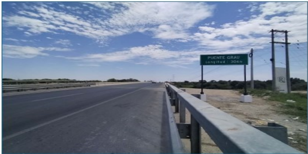
Vista de Carretera de Acceso
