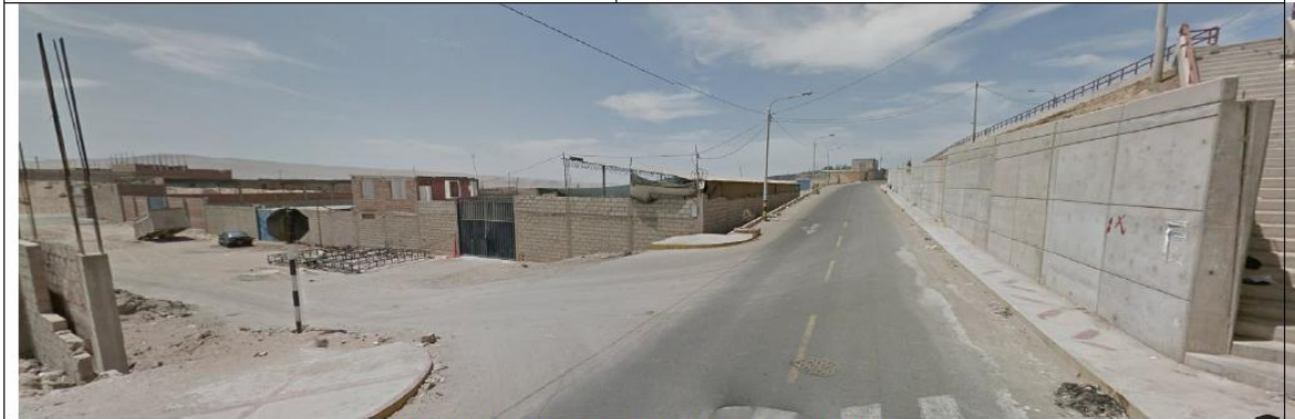
VISTA PANORAMICA DEL INMUEBLE
